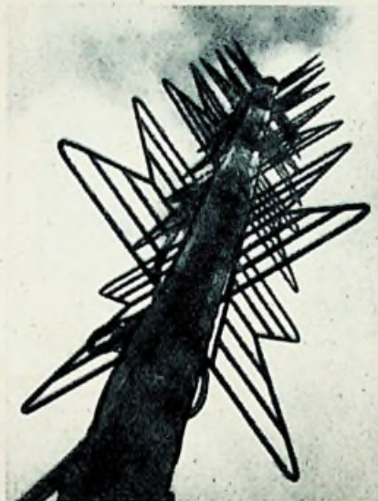
Radiotélé Paris schonk de Eiffeltoren deze „hoed“. Links een dichtbij-beeld van de antenne van de 819-lijnen zender, rechts vindt men deze geheel aan de top.
